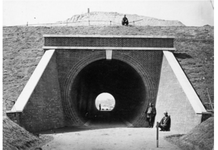
完成間近の石屋川トンネル(古写真)
